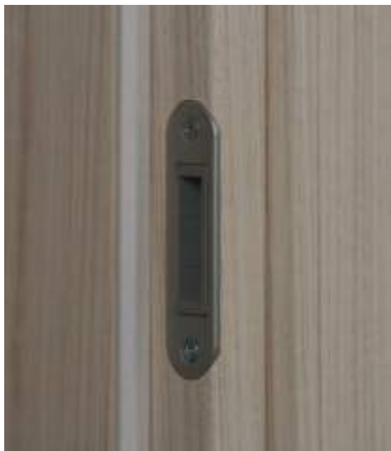
Incontro serratura meccanica / Mechanical lock Striker
